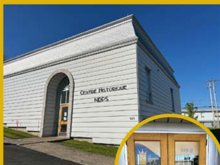
Entrée par la porte de côté
